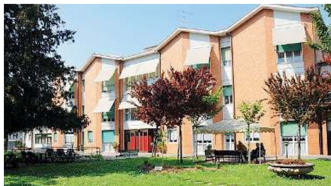
La struttura. La Rsa Almicci di Rezzato
